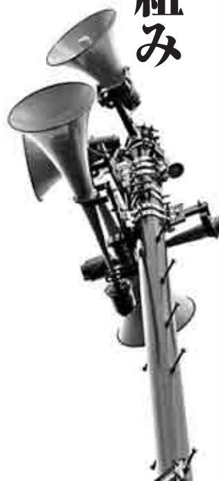
▲サイレン遠隔吹鳴装置
