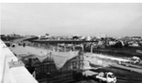
▼さがみ縦貫道路の工事の様子
