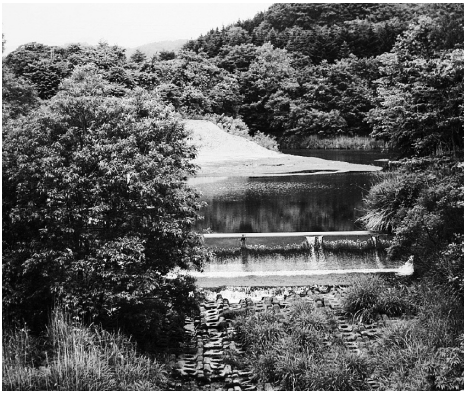
▲幌別浄水場取水口
