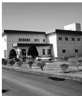
▲若山浄化センター
