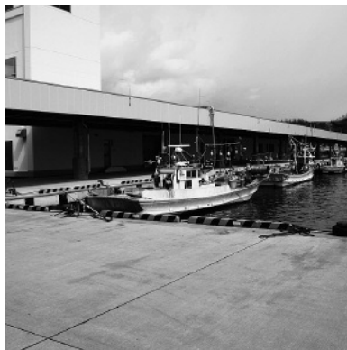
▲登別漁港屋根付岸壁
