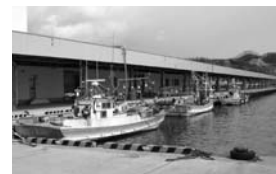
▲登別漁港屋根付岸壁
