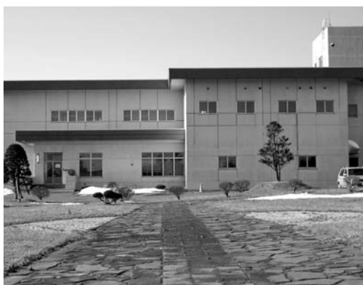
▲若山浄化センター
