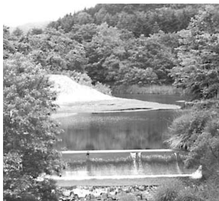
▲幌別浄水場取水口
