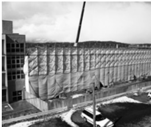
▲建設中の市営幌別東団地
