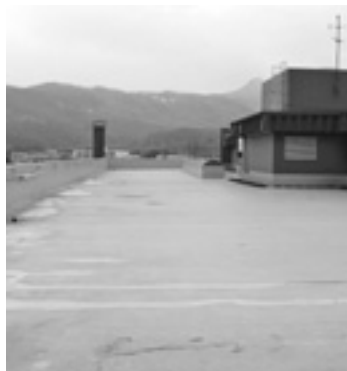
▲防水改修工事を終えた市民会館の屋上
