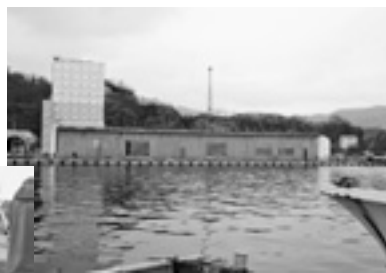
▲建設中の新しい荷捌き場
