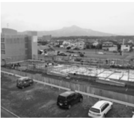
▲建設中の幌別東団地
