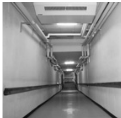
▲入園者に支障のないよう天井に設置した給湯管と給水管
