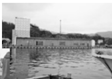
▲建設中の新しい荷捌き場
