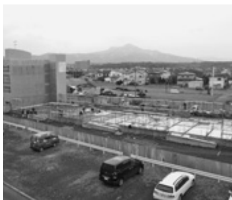
▲建設中の幌別東団地
