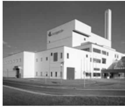
▲クリンクルセンター
