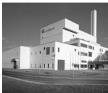
▲クリンクルセンター
