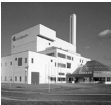
▲クリンクルセンター
