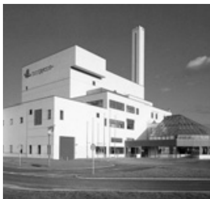
▲クリンクルセンター
