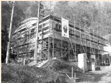
登別温泉浄水場全面外壁補修工事（事 業費3,500万円）
