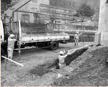
登別温泉バイパス工事に伴う配水管の 移設工事（事業費1,500万円）
