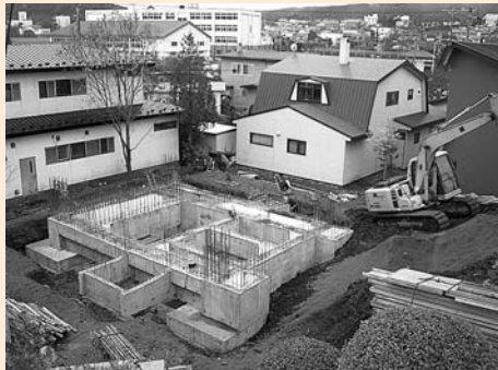
老朽化の著しい美園ポンプ場を新たな 場所に建設（事業費4,000万円）
