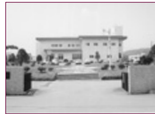
▲若山浄化センター
