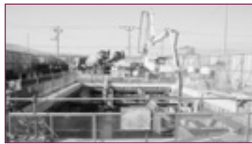
▲建設が進む幌別ポンプ場
