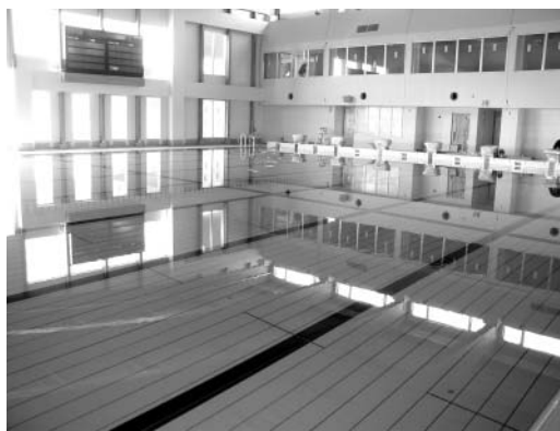
プール槽に水を張った新市民プール内部
