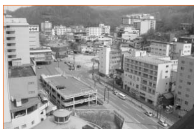
第1工区終点から第2工区を臨む
