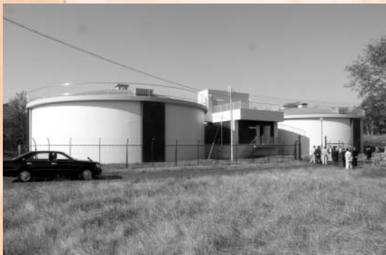
柏木配水池通水式 (10月27日)
