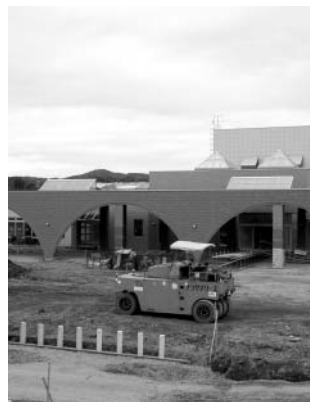
建設中の新火葬場
