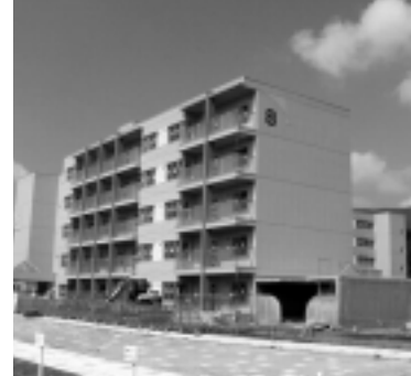
▲完成した桜木団地8号棟
