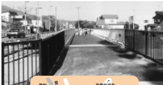
◀10月22日に完成した「登別橋歩道橋」
