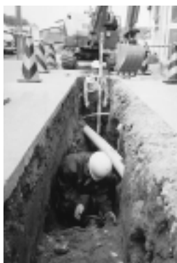
▲配水管改良工事
