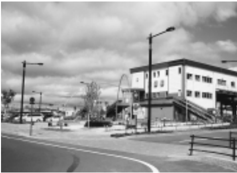
▲平成12年度に整備されたJR幌別駅前広場
