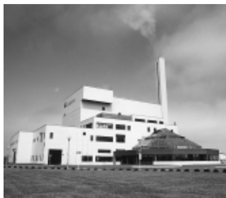
▲クリンクルセンター
