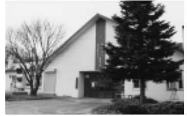
▲旧札内小中学校を改修して設置された札内高原館。
