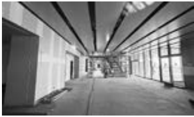
▲建設工事の様子（市民ロビー正面）
