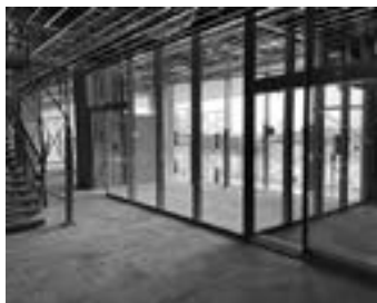
▲建設工事の様子（会議室）
