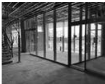
▲建設工事の様子（会議室）
