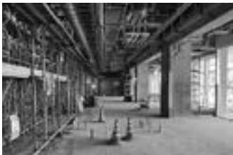
▲庁舎内部（1階）の様子
