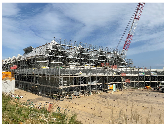
建設工事の様子
