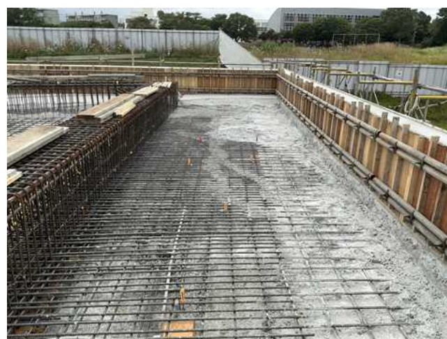
中止したコンクリート打設工事の写真
