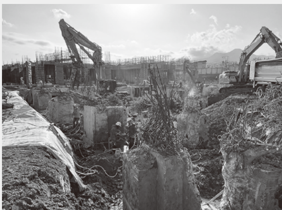
▲やり直し工事を行った様子（庁舎東側・令和7年4月）
