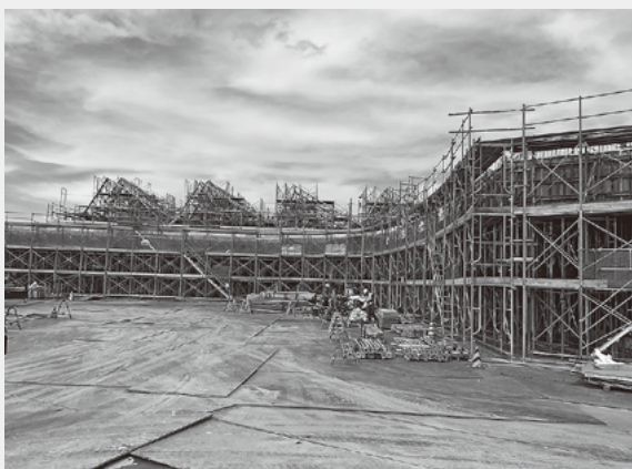
▲令和7年6月時点の建設工事の様子（正面玄関）
