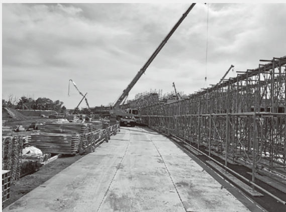
▲令和7年6月時点の建設工事の様子（庁舎南ひろば側）
