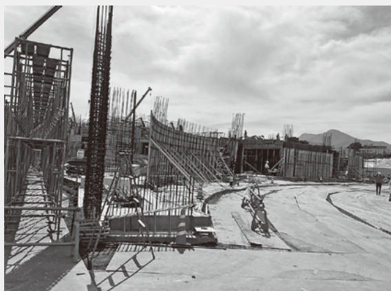
▲令和7年6月時点の建設工事の様子（庁舎東側）
