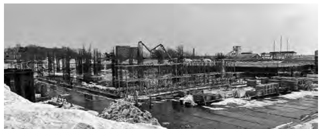
◀ 建設工事の様子
