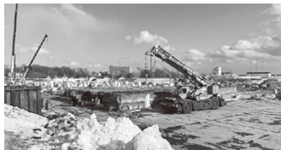
▲建設工事の様子
