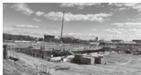
▲建設工事の様子
