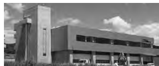
▲令和7年4月に供用開始予定の新消防庁舎
