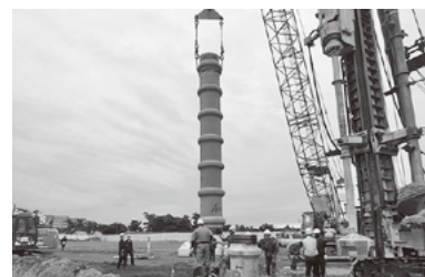
▲くい打ち工事の様子
