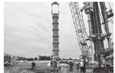
▲くい打ち工事の様子
