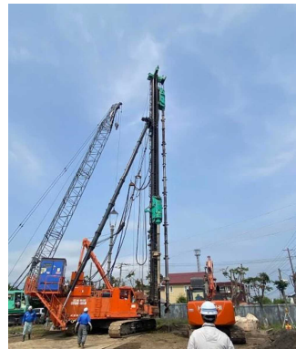
令和6年7月 杭工事の様子
