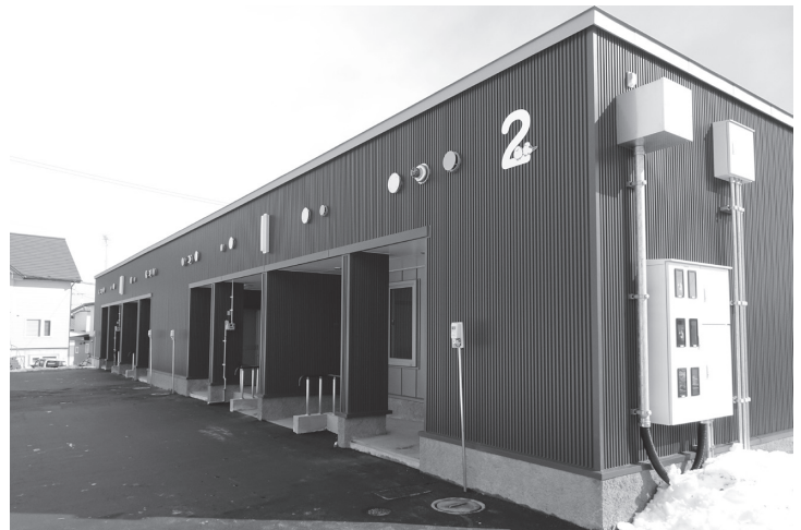
▲完成した子育て支援住宅
