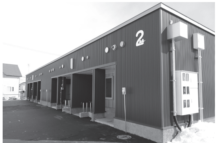
▲完成した子育て支援住宅
