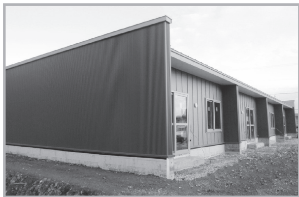
▲建設中の子育て支援住宅の外観
