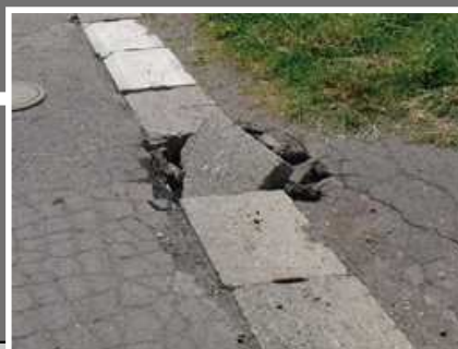
排水溝の破損
