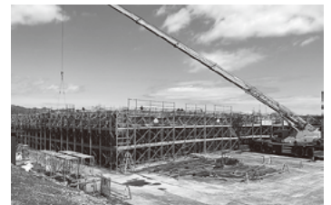
▲建設工事の様子
