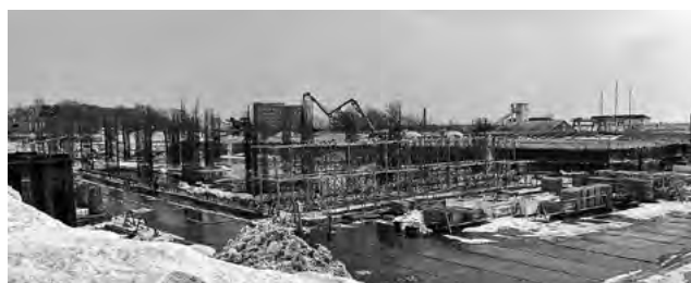
建設工事の様子
