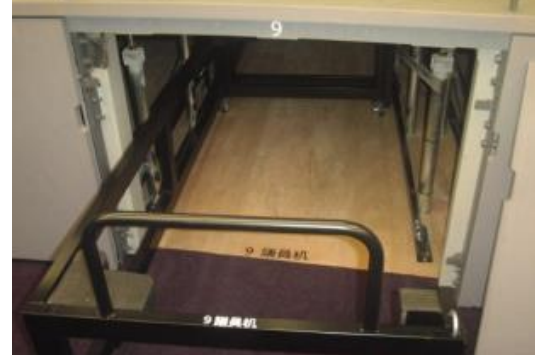
【写-40】 参考 机等は可動式で収納できる。壁も取り外し可能であり議会以外の活用も可能。（新潟県新発田市）
