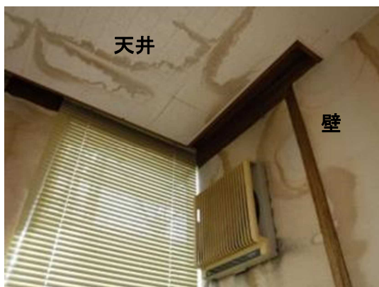
【写-12】庁舎内で慢性的に雨漏りが発生し、市長室においてももの雨漏りで壁クロスが変色
