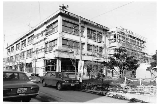
昭和49年本庁舎増築工
