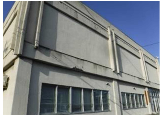
【写-11】第2庁舎（上記写真）においても老朽化が進み、外壁コンクリートの剥離が発生
