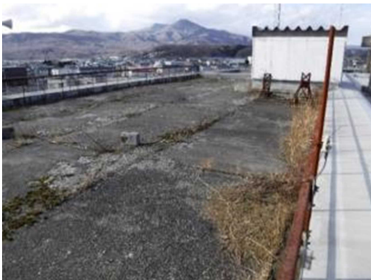
【写-10】老朽化等により剥離やひび割れなどが発生している庁舎屋上
