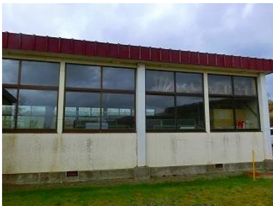
5-3 外壁② (実習棟)
