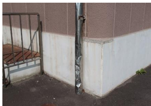
14-4 屋根・屋上（雨水ドレン）
