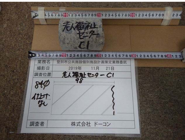
コンクリートコア採取の状況
