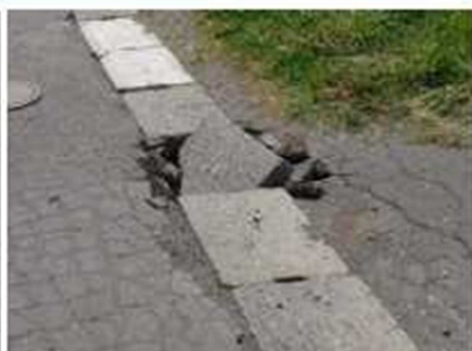
側溝のふた破損
